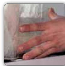
Verklebung unter Fensterleisten
